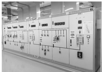
แผงสวิตช์ไฟฟ้าแรงต่ำ (Low – Voltage Switch Board)
